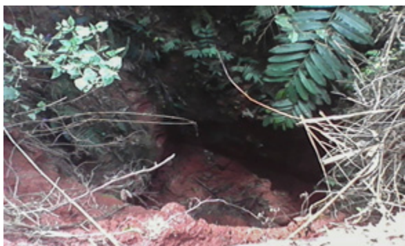
fig. 3 – Site de l'éboulement de terre pour cause de mauvais creusement. Photo : Damien Enama, août 2016
