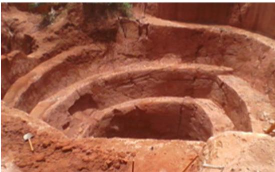
**fig. 2** – La technique de creusement en spirale.
