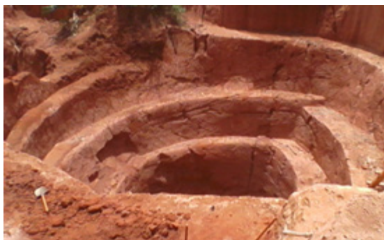
fig. 2 – La technique de creusement en spirale. Photo : Damien Enama, août 2016
