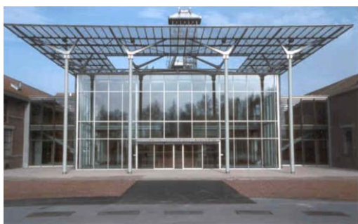
Bâtiment d'accueil © Centre Historique Minier
