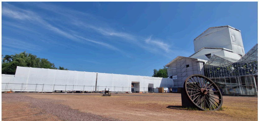
Montage de l'échafaudage et des bâches sur la passerelle des mineurs
