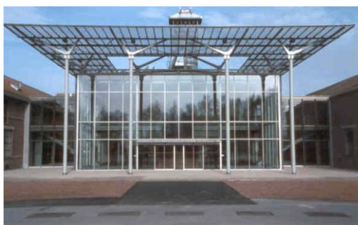
Bâtiment d'accueil © Centre Historique Minier
